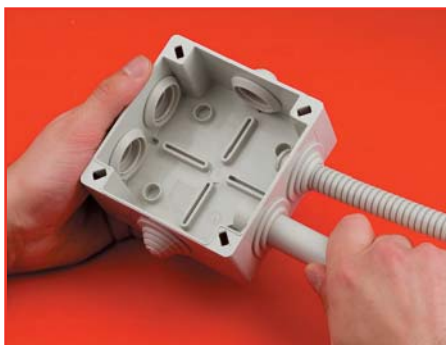
Заводим гофрированную и жесткую трубы
