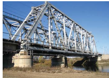
Объекты инфраструктуры Мосты, тоннели, конструкции с малым количеством опор
