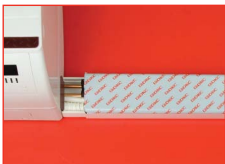
Закройте смонтированную трассу крышкой
