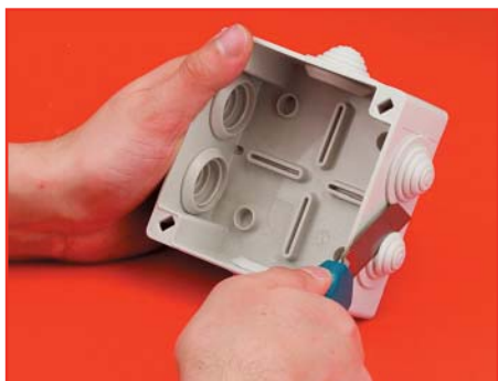
Срезаем кабельный ввод
