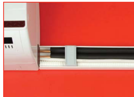
Закрепите трассу в основании короба при помощи фиксирующих скоб
