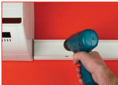
Закрепите основание короба на стене
