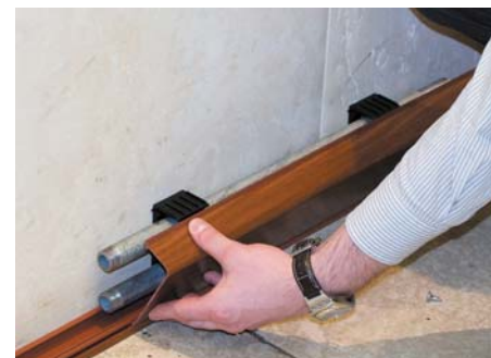
Система закрывается декоративной крышкой
